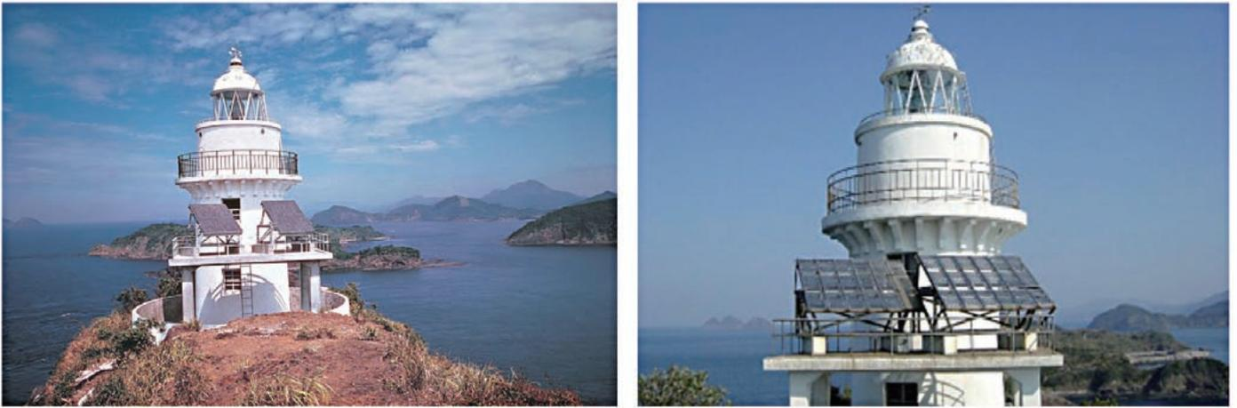
図5 尾上島の太陽光発電システム（左がS224モジュール使用、10年後に右のS225に交換された）（写真提供：海上保安庁）
