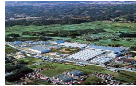
栃木事業所〈栃木県矢板市〉
