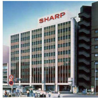
東京市ヶ谷ビル〈東京都新宿区〉
