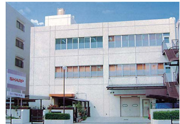
地域の支援もあって竣工した、合資会社早川特選金属工場の新社屋(新工場)
