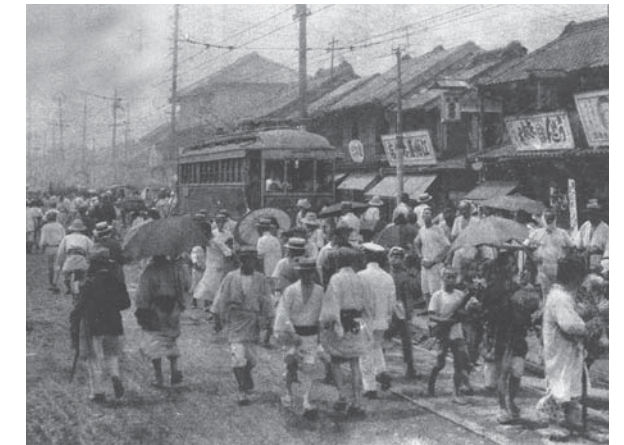
余震と火の手に大混乱の東京市本所区石原町付近(朝日新聞社提供)
