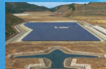
シャープ多奈川太陽光発電所 建設から発電事業の運営までを実施
