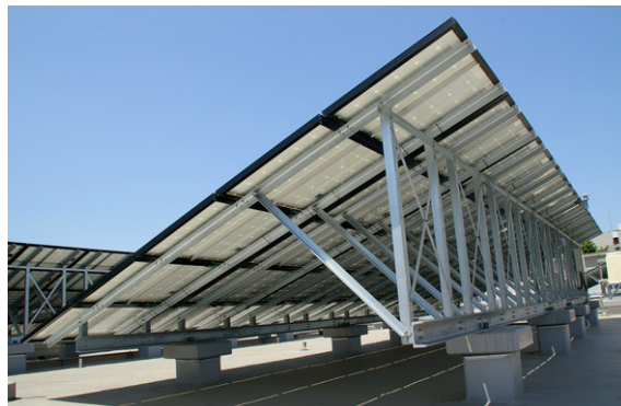
駒場1キャンパス9号館屋上にコンクリート基礎を新設し、架台を組み、太陽電池モジュール280枚(50kW)を設置
