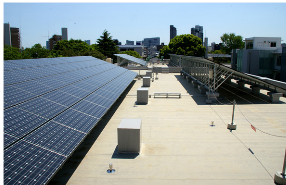
駒場1キャンパス9号館屋上にコンクリート基礎を新設し、架台を組み、太陽電池モジュール280枚(50kW)を設置
