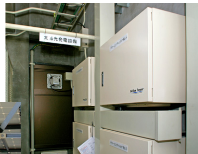
電気室にパワーコンディショナ10kWを5基設置し、学内で使用する電力に変換
