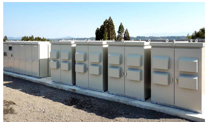
1.16MWの発電を処理する4台のパワーコンディショナ
