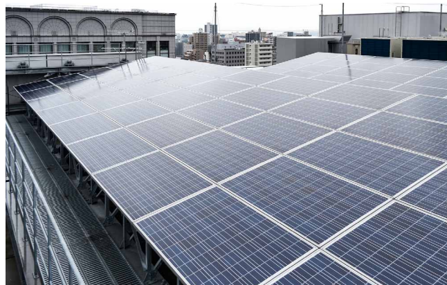
85台のソーラーパネルを、地上11階建のビル屋上に南東向きで設置
