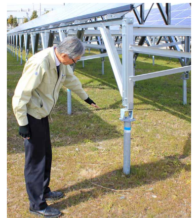
グラドスクリューの実物と、地面にねじ込まれた基礎の様子
