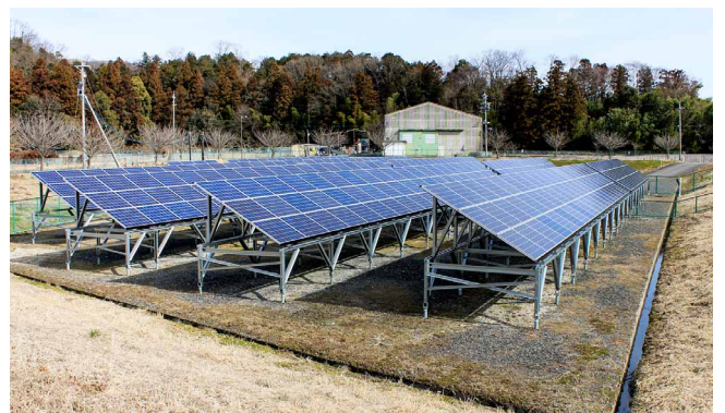
大野町運動公園内北側調整池。豪雨の際には架台の下まで雨水を貯めることができる
