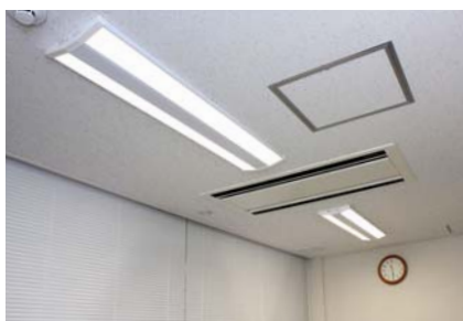
商談室や会議室などにはLED照明を導入。太陽光発電システムとの相乗効果で一層省エネに
