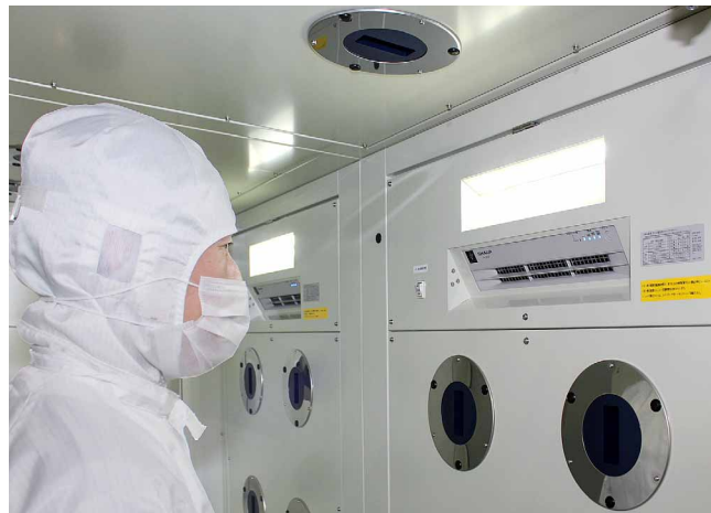
プラズマクラスターイオンの除電効果により、エアシャワーの異物除去性能を向上
