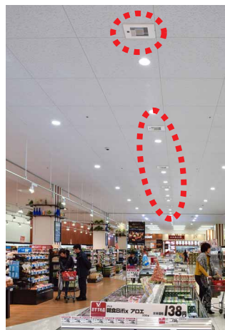
冷蔵・冷凍平ケースの真上に埋込型を40台設置。結露によるカビ菌抑制に
