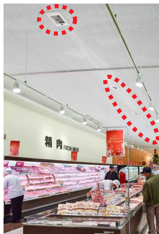
冷蔵・冷凍平ケースの真上に埋込型を40台設置。結露によるカビ菌抑制に
