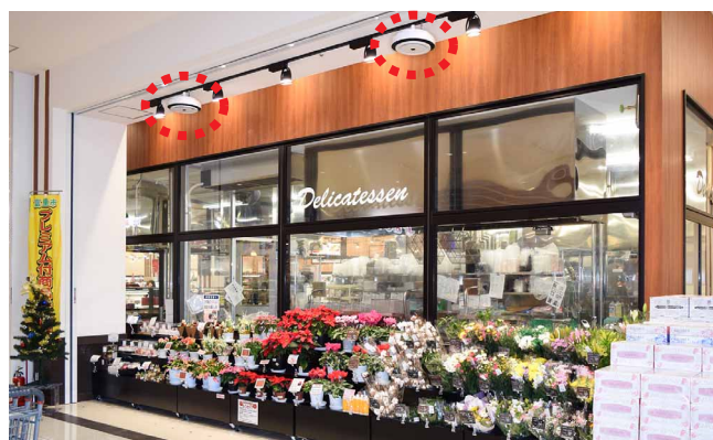
生花コーナーにも照明の配線を利用して天井吊り下げ型を設置
