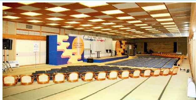
ホテルの会場にイオン発生機を30台設置しお客さまを守った
