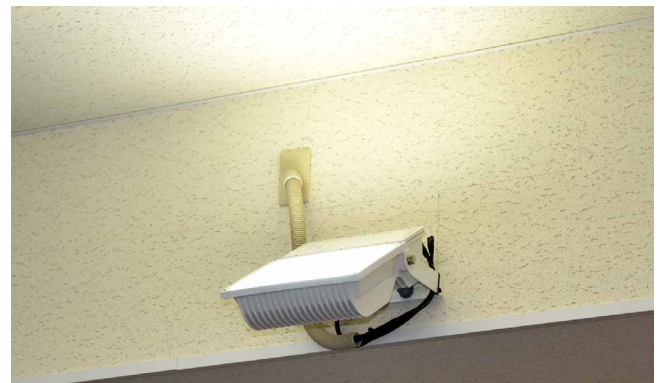
設置角度を10度単位で可動できるので、まぶしさを抑えながら最適な明るさとなるように調整可能
