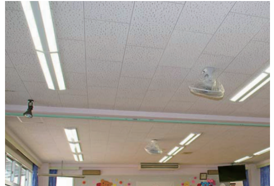
床面が明るくなり作業がしやすくなったと好評
