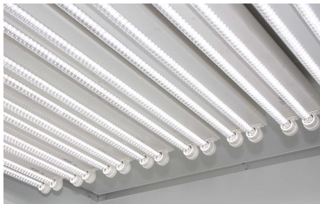
既設の蛍光灯器具・ソケットがそのまま使用できる直管LEDランプ
