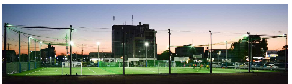
優れた配光制御でコートだけを照らし、周辺への光の漏れが低減できる点もメリット
