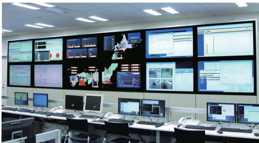
オペレーションデスク前に設置された12面マルチの『PN-525』。中央の4面は拡大表示で大規模なネットワーク監視状況を表示。その他は1面ごとに個別の情報を表示。
